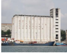
a) TMO'ya ait betonarme bir tahıl silosu
